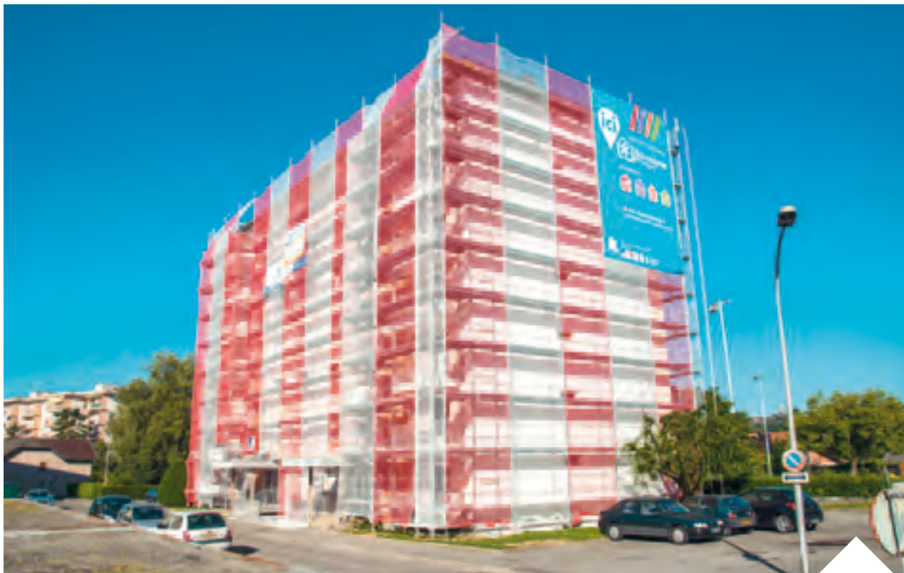
Rue des Nemours à Meythet, un bâtiment en cours de rénovation.
