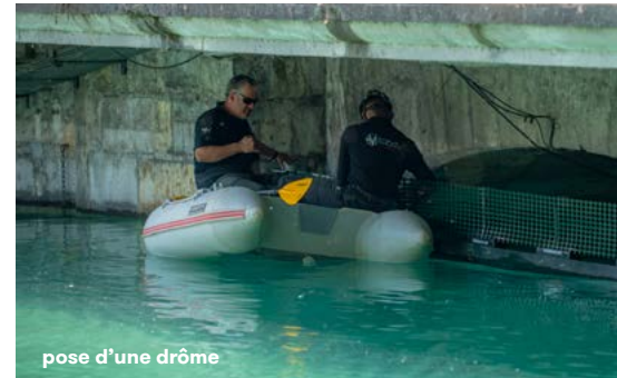
pose d'une drôme
